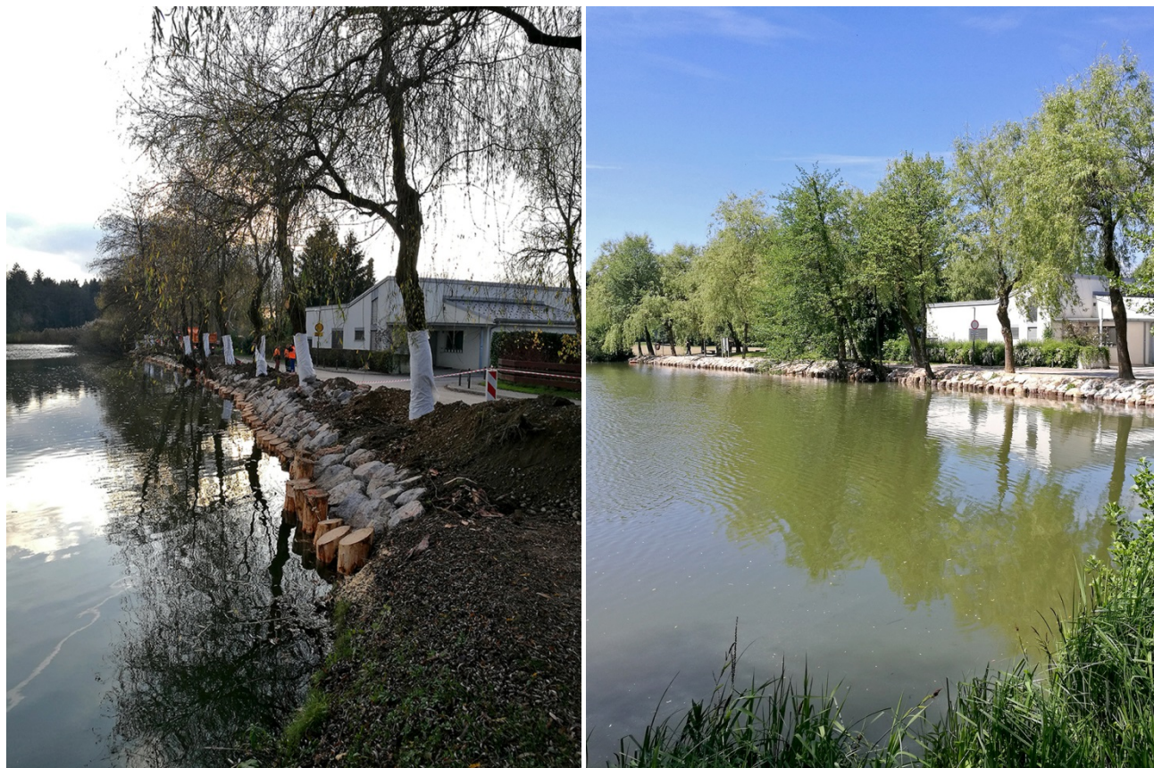
Sliki 7 in 8: Utrjevanje SZ brega Koseškega bajerja s kamnometom 15. 11. 2018 (levo) ter gol breg 24. 5. 2019 (desno), foto Ali Šalamun.
