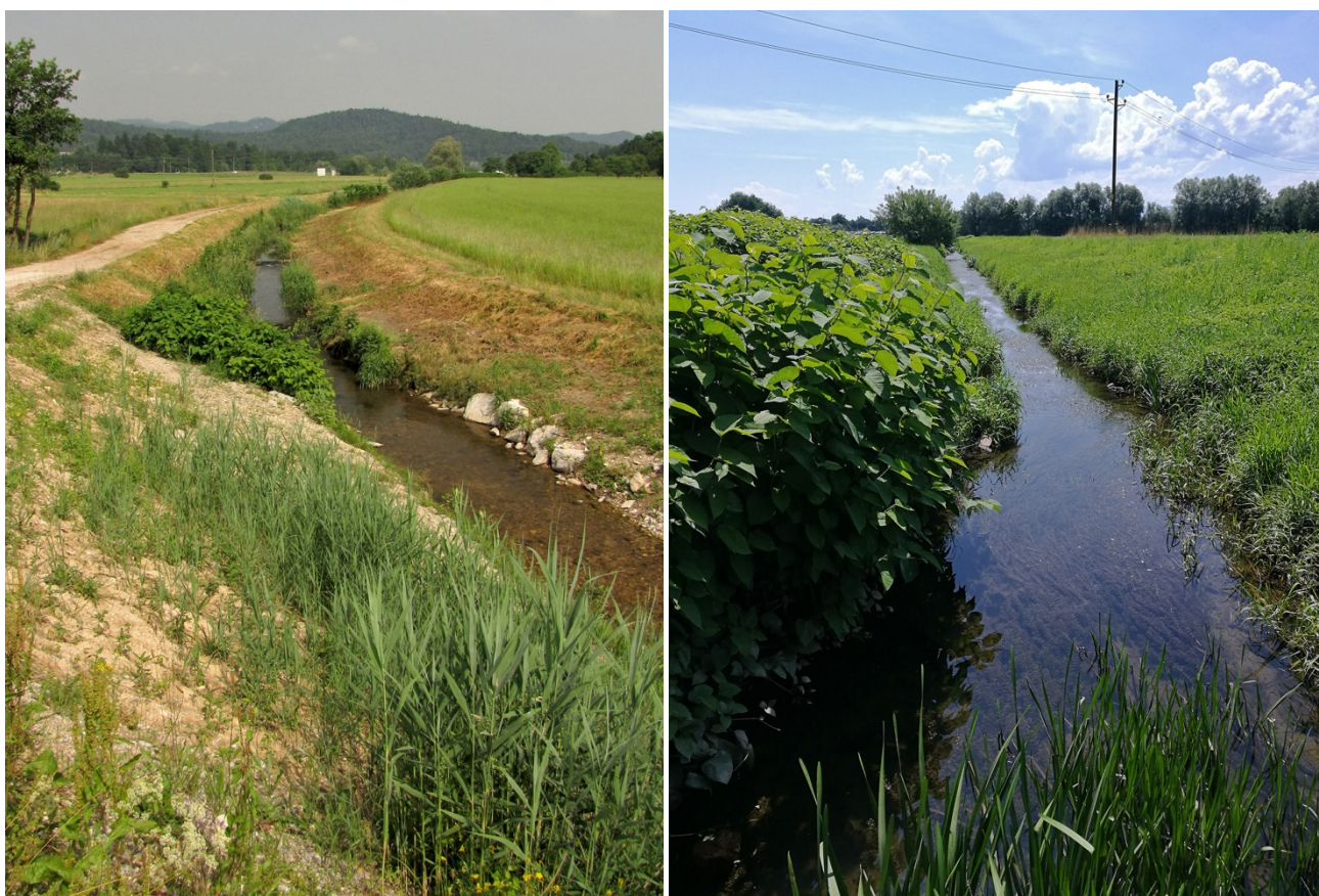
Sliki 17 in 18: Potok Glinščica pri mostu na Poti Roberta Blinca na Brdu (levo) in iztok potoka Pržanec v Glinščico (desno), foto Ali Šalamun, 11.6.2019 (levo) in 10.7.2018 (desno).
