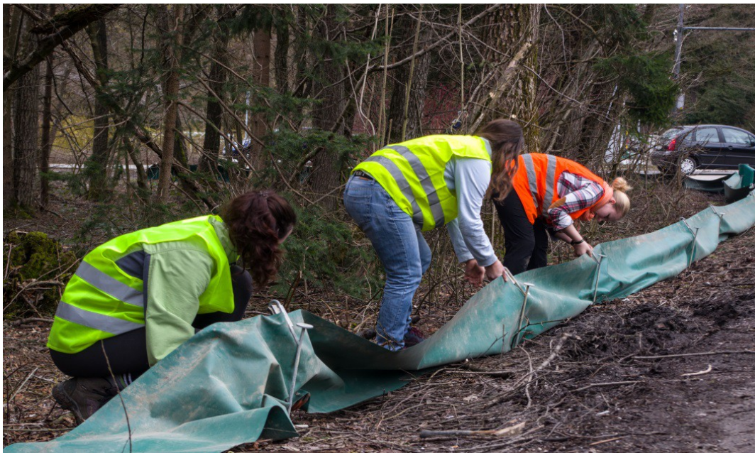
Slika 1: Postavljanje ograje. (foto: Rudi Kraševac).
